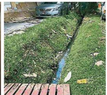
万挠新村的旧式沟渠太狭小，每逢大雨便倒灌至马路，对村民的出入造成不便。
