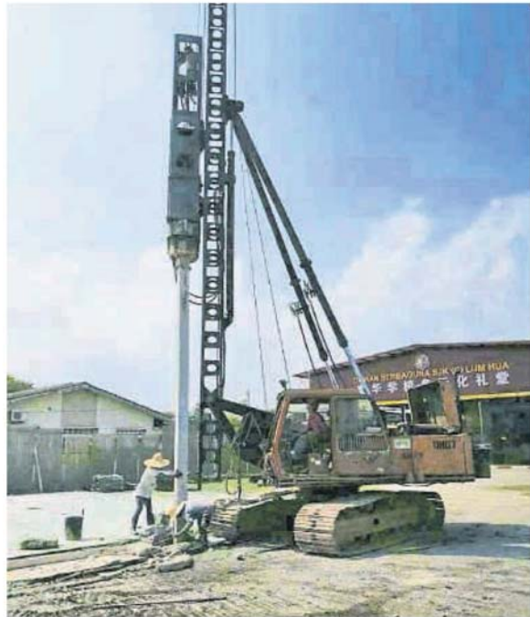
■南华小学打桩兴建讲堂和会议室。
