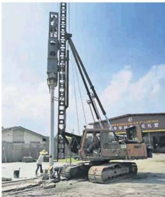
工人正在打桩。
